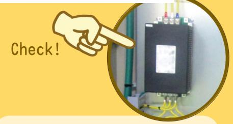
発生したノイズは電線を通じて他の機器へ伝わります。 写真の施工例では、高減衰フィルターを設置し他の盤か ら入ってくるノイズを防ぎます。
