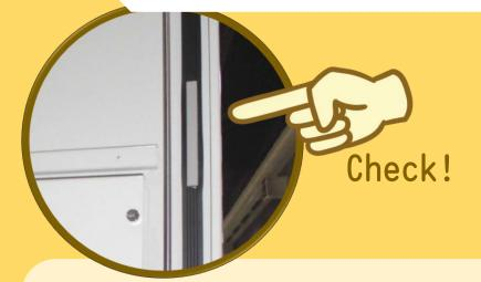
ノイズは電線をアンテナとし、ラジオの電波のように空中にも放出されます。制御盤の箱体は鋼板製ですのでノイズを通さないとされていますが、構造によってはノイズが漏れ出ることもあります。写真の施工例ではゴムパッキンの一部をシールドパッキンに変更。放射ノイズが扉の隙間より漏れ出ることを防ぎます。
